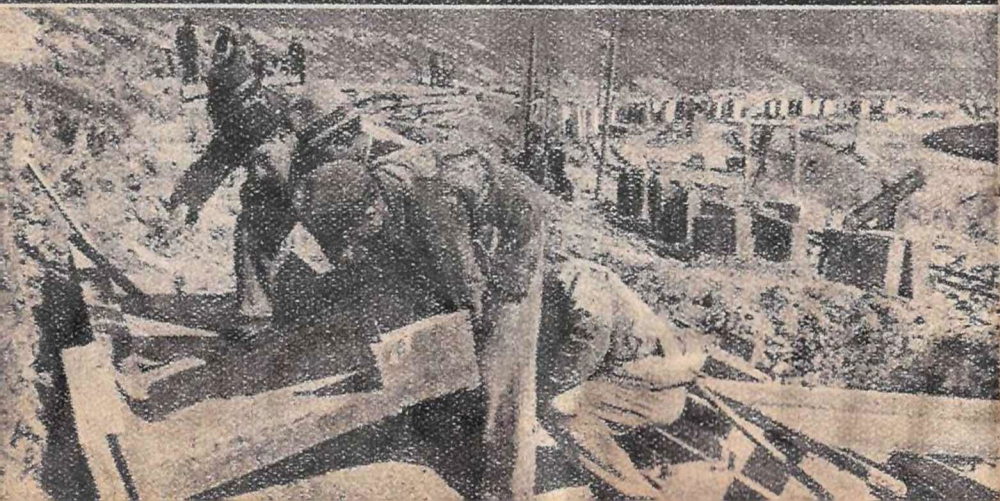
Előregyártott öbőelemek elhelyezése
